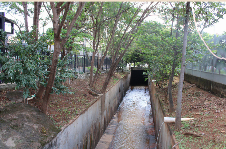
FIGURA: CÓRREGO DAS ANTAS - TRECHO CANALIZADO
