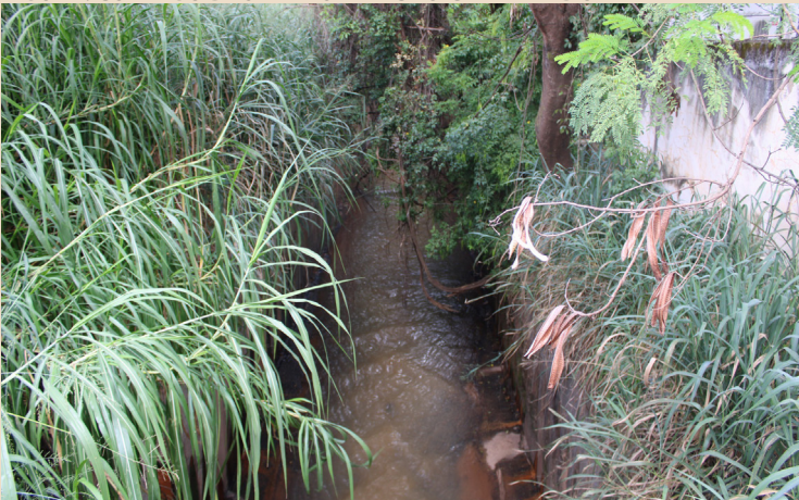
FIGURA: CÓRREGO DAS ANTAS - TRECHO CANALIZADO
