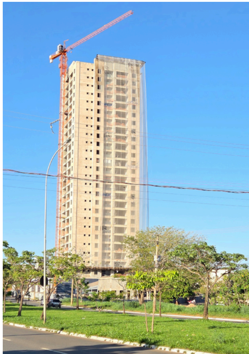
Fig. 58. Edifício Sunset Residence - Av. Pedro Paulo de Souza. No lançamento foi divulgado como o primeiro edifício de alto padrão da região (entrega em 2027) Fonte: foto do autor (2025)
