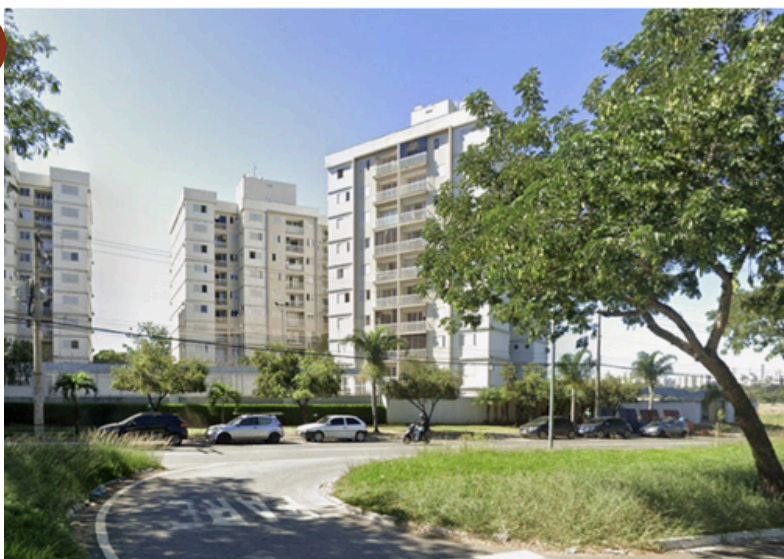
Fig. 42. Edifício Happy Days - Av. Pedro Paulo de Souza Fonte: foto do autor (2025)
