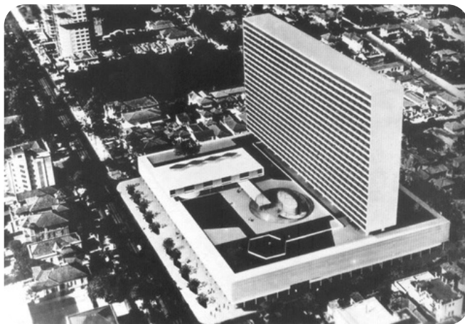
Figura 15: Fachada Conjunto Nacional - Av. Paulista
