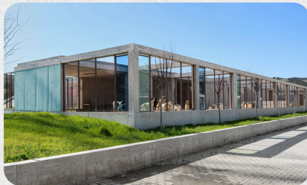
Figura 18 - Centro Social Veterinário Pako Street
