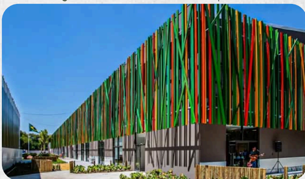
Figura 54 - Fachada brises metálicos pintados
