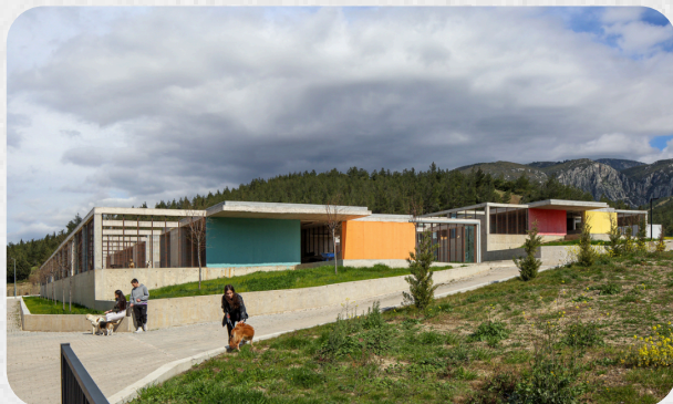
Figura 15 - Centro Social Veterinário Pako Street
