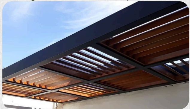
Figura 53 - Cobertura metálica com ripas de madeira
