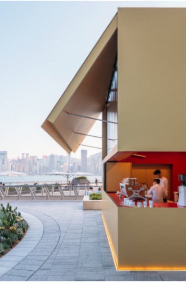
IMAGEM 67 - Estrutura de proteção solar
