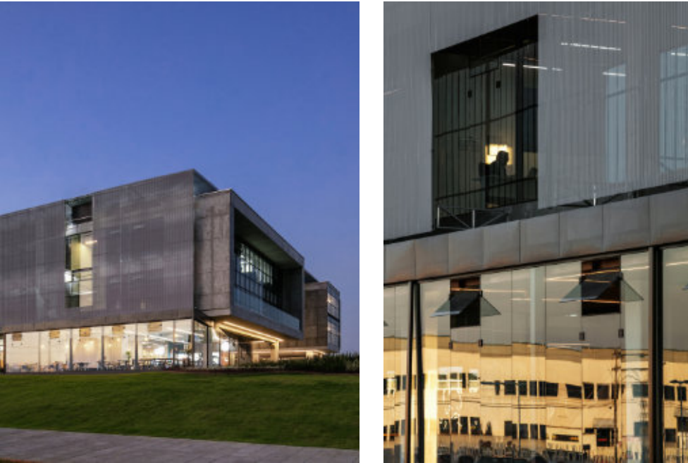
IMAGENS 37 E 38 – Técnicas construtivas em fachada
