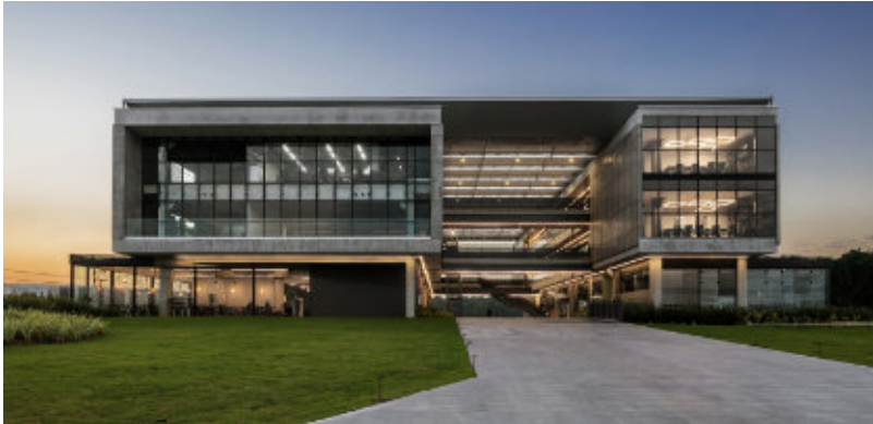
IMAGEM 24 - Agora Tech Park, Fachada Posterior
