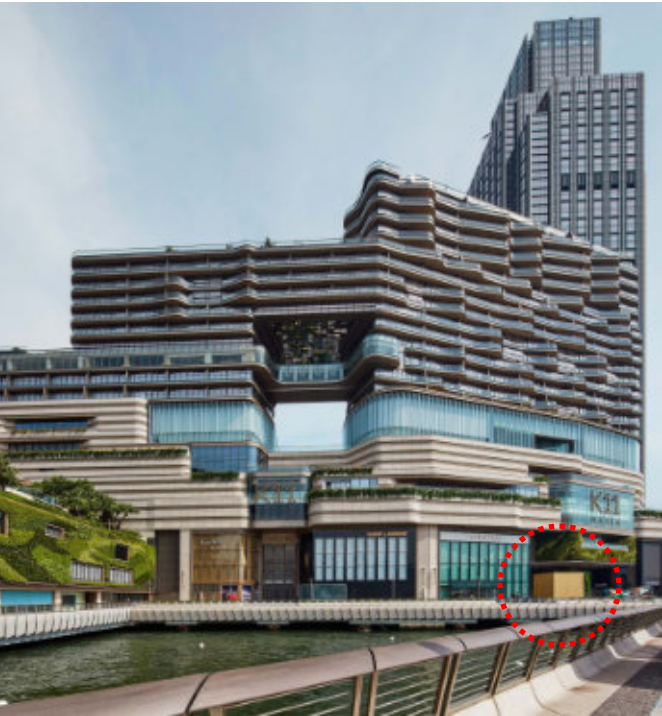
IMAGEM 61 -Edifício K11 Musea, Hong Kong
