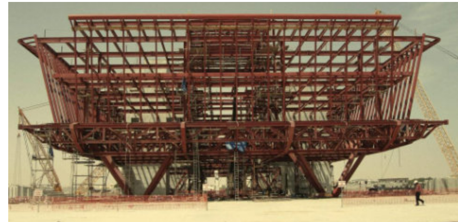
IMAGEM 55 – Construção do centro de incubadoras
