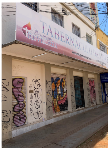
Figura 74: Degradação do espaço público..
