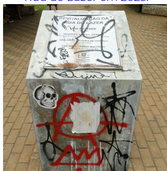
Figura 33: Depredação da Rua do Lazer em 2023.
