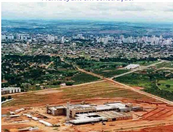
Figura 7: Vista aérea de 1980-81, com o Shopping Flamboyant em construção.
