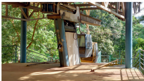
POPULAÇÃO RECLAMA DE ABANDONO E FALTA DE ESTRUTURA NO PARQUE BOTAFOGO | G1 GOIÁS
