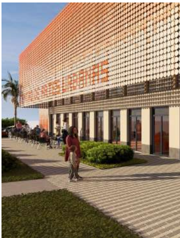
DETALHE DA FACHADA
