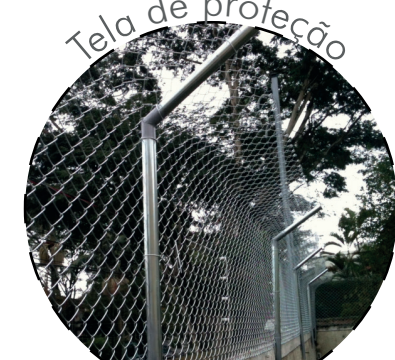
Tela de proteção Tela de segurança em aço galvanizado e formato losangular.
