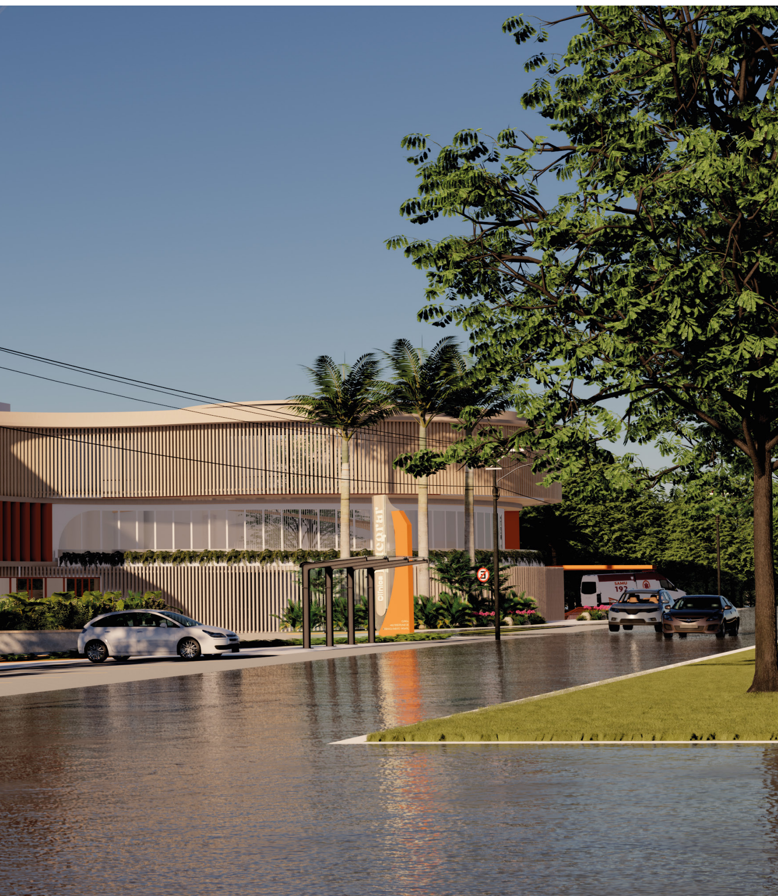
Figura 56: Fachada vista da Av Bela vista sentido terminal Isidória Fonte : Autoria própria
