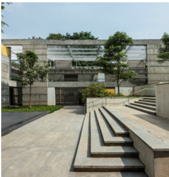
Figura 72- Lateral IIM. Fonte: Archdaily.
