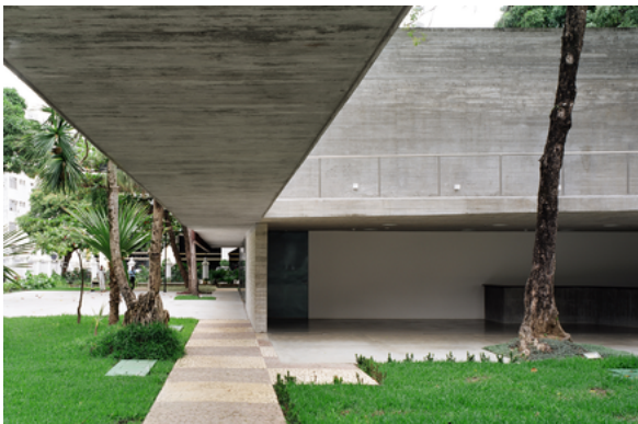
Figura 86 - Passarela entre os edifícios. Fonte: Brasil Arquitetura.
