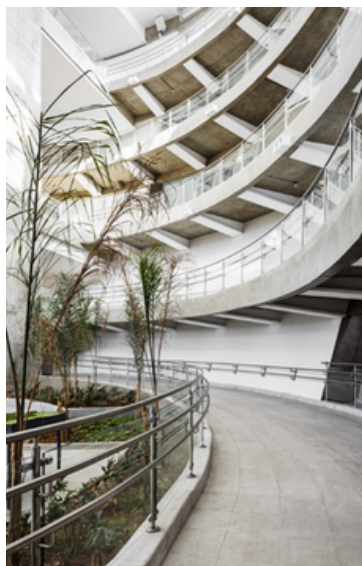
Figura 60- Materialidade. Fonte: Archdaily - Ana Mello.
