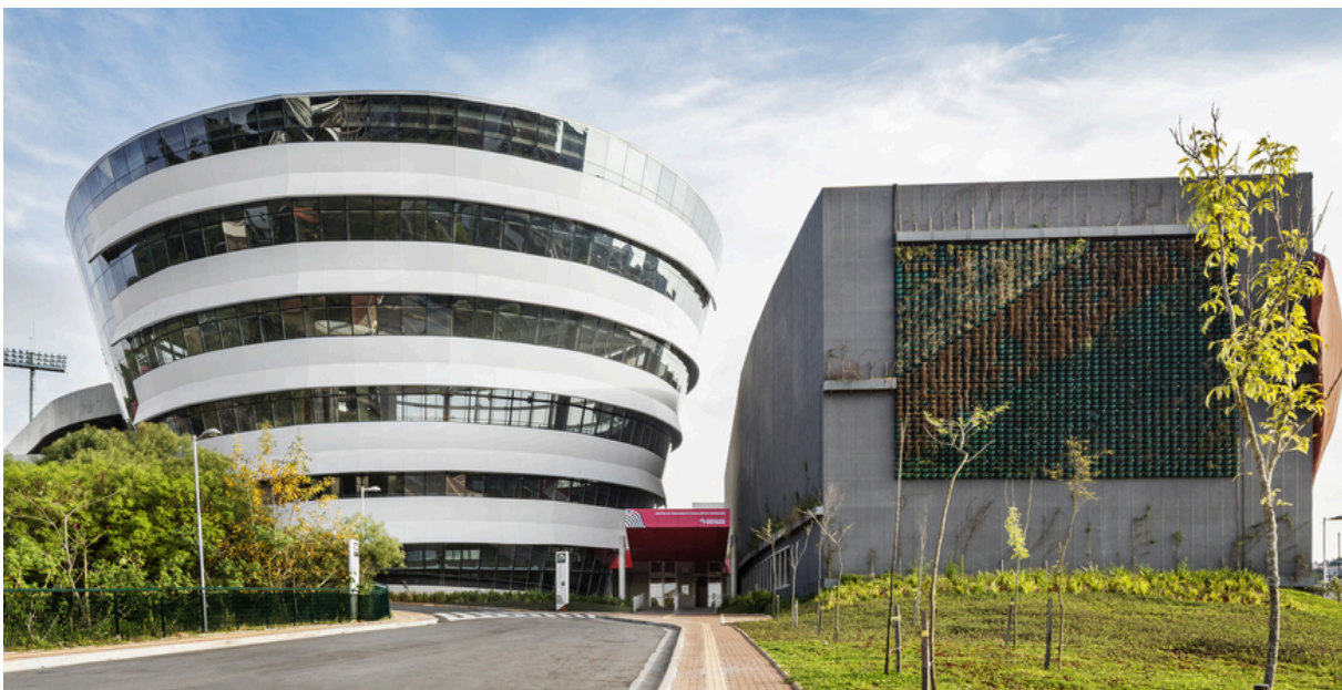
Figura 57 - Fachada Centro Paraolímpico Brasileiro. Fonte: Archdaily.
