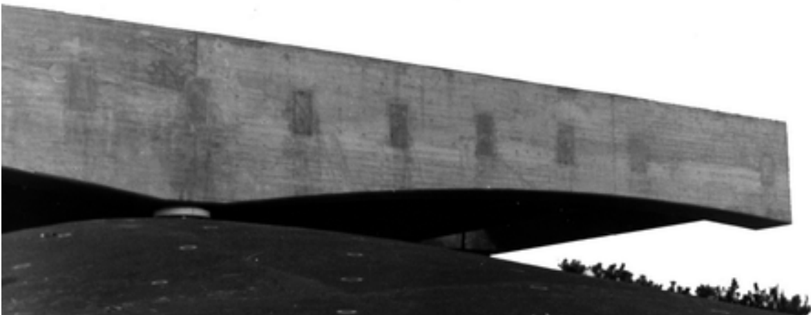
Figura 44 - Fachada do Pavilhão do Brasil em Osaka. Fonte: Archdaily.
