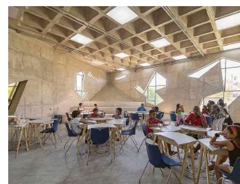
Laje abertura em vidro transitável
