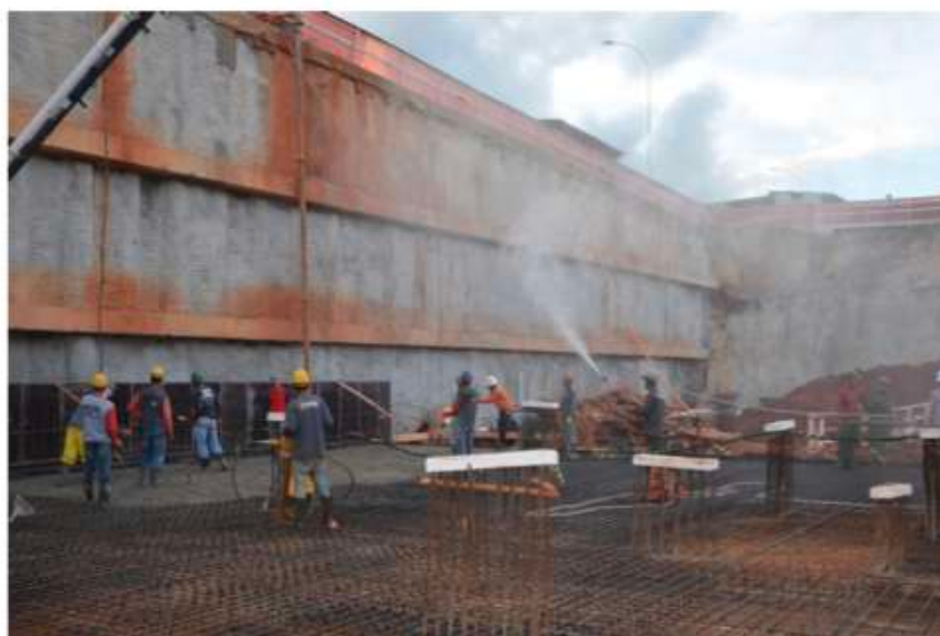
Exemplo de edificação monolítica estanque, com uso aditivo cristalizante (Setor Noroeste/Brasília, 2017)
