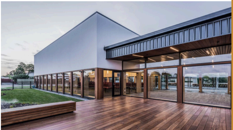
IMAGEM: PATIO DE CONVIVÊNCIA DA IGREJA METODISTA DO NORTE EM CHRISTCHURCH - FONTE: STEPHEN GOODENOUGH
