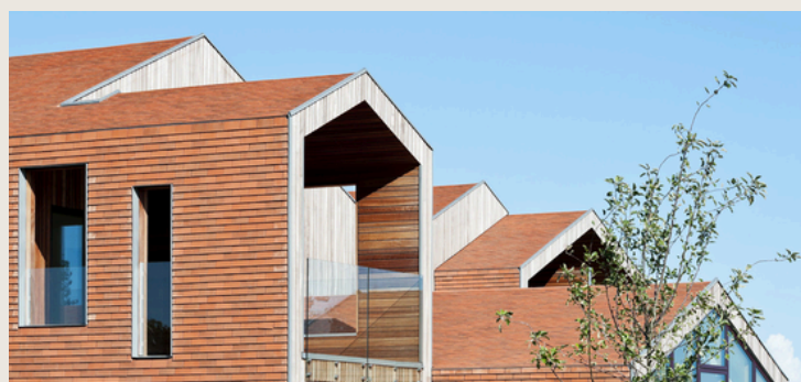
Figura 17: Fachada Centro de Acolhimento para menores
