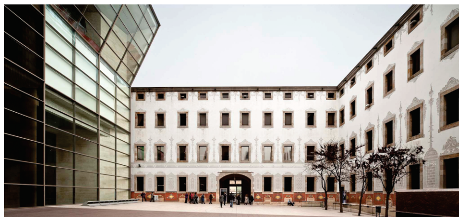
Imagem 07: Vista geral do pátio central após a intervenção
