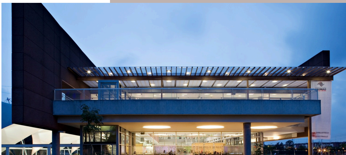
Figura 31 - Fachada Leste - Presença de Vidro e Concreto
