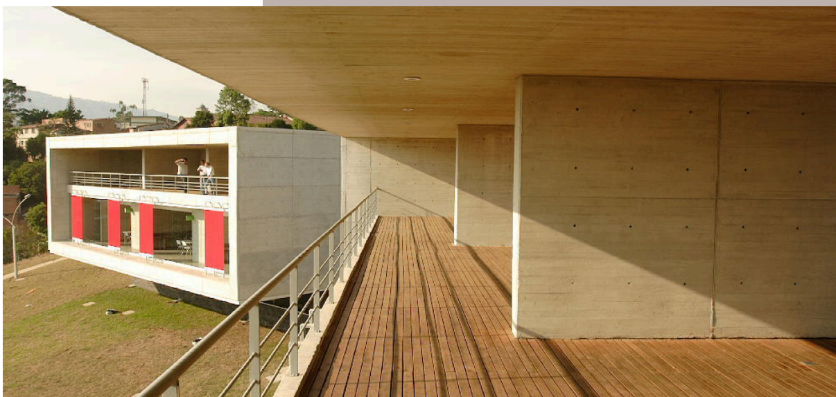
Figura 24 – Biblioteca – Uso de Concreto e Madeira nas Varandas
