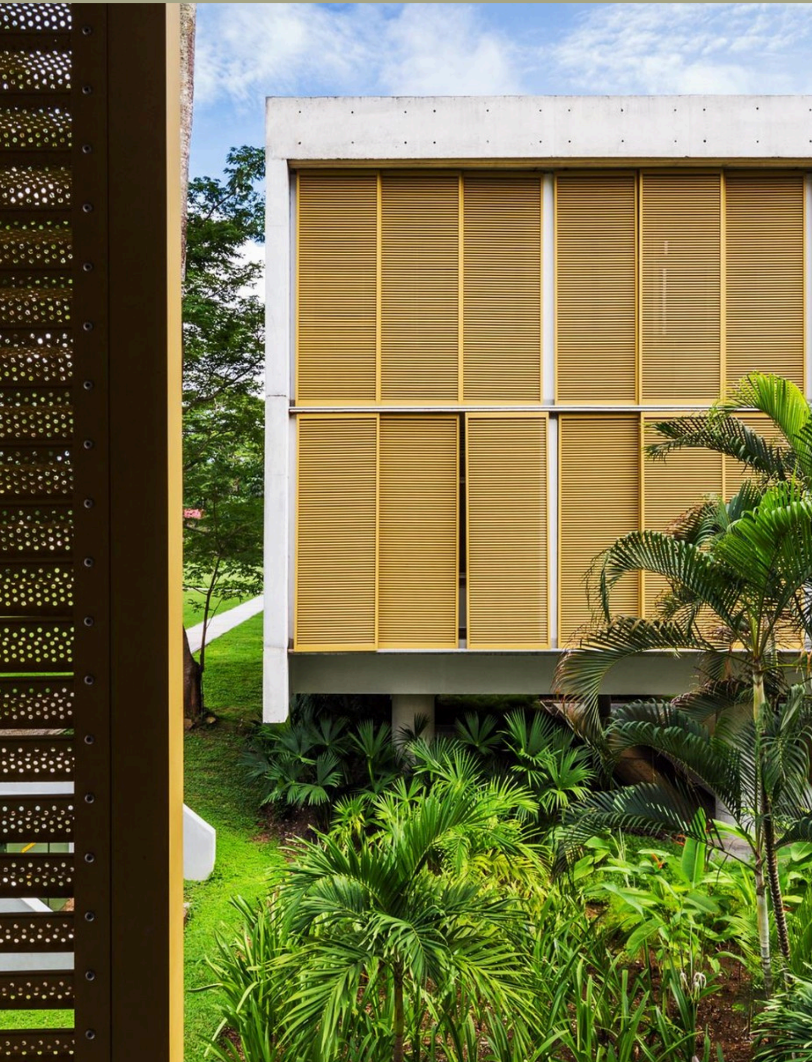
Figura 11- Fachada com brises
