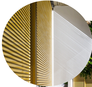
Figura 15- Sistema de grelhas para ventilação natural transversal
