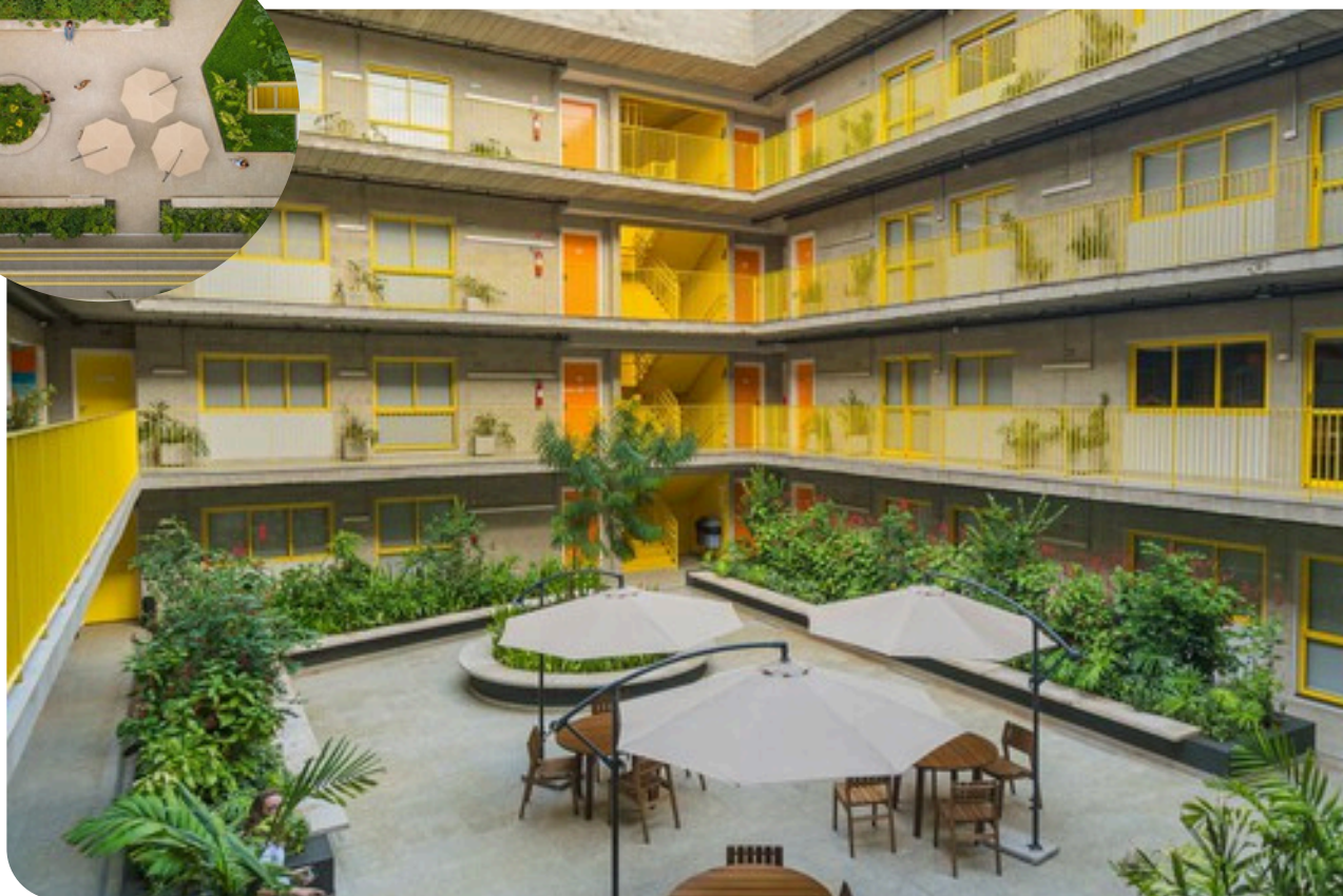
Figura 40- Pátio interno, vista das passarelas setor íntimo
