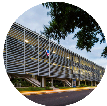
Figura 14- Brises e elementos de sombreamento em alumínio
