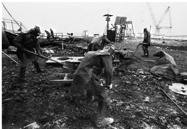
Figura 2.12: 'liquidadores' retiram escombros nos arredores da central de Chernobyl.
