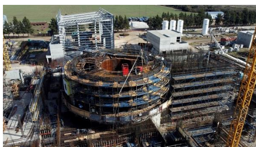
Figura 3.2: Reator CAREM em construção, na Argentina.
