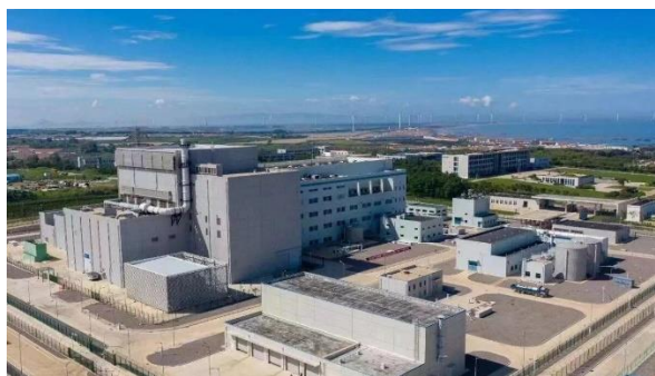
Figura 1.12: Usina de Shidaowan com Reator HTGCR de Quarta Geração.
