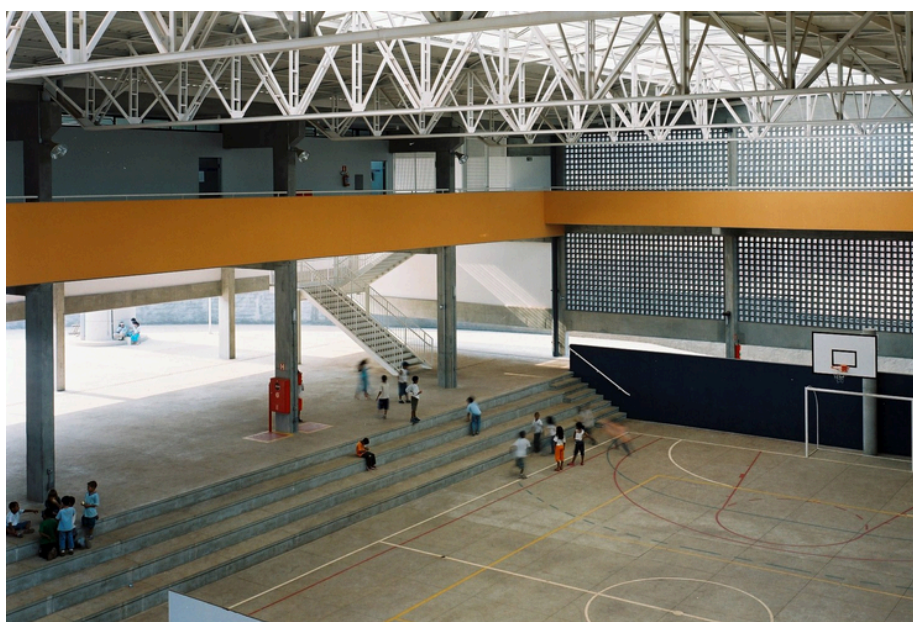
Figura 16: Vista da quadra poliesportiva e pavimentos superiores.
