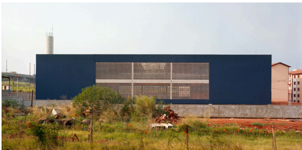
Figura 8: Fachada da escola.
