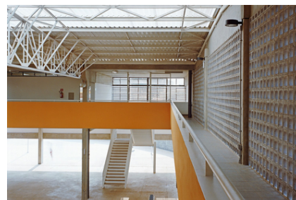
Figura 13: Vista do corredor do pavimento superior.
