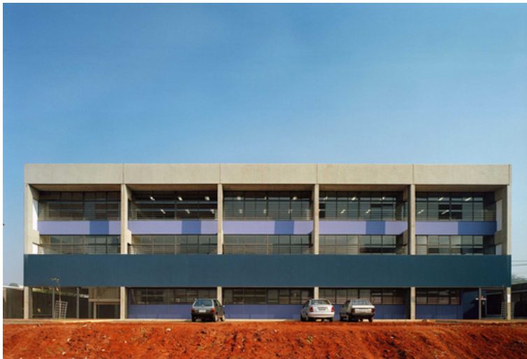
Figura 7: Fachada da escola.
