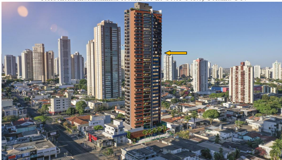
Figura 3 - Vista geral do edifício objeto do estudo, representando o empreendimento residencial multifamiliar localizado no Setor Oeste, Goiânia/GO.
