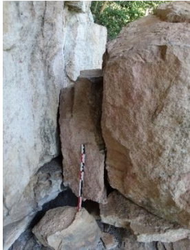
Figura 53 - Fotografia do bloco que impede a passagem para o setor GO-CP-28B
