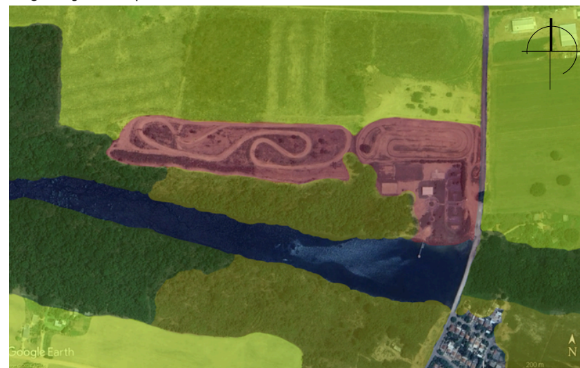
Fig. 42 - Zonas de Degradação
