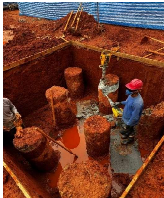
Figura 10 – Arrasamento das estacas. Fonte: Autores (2025)
