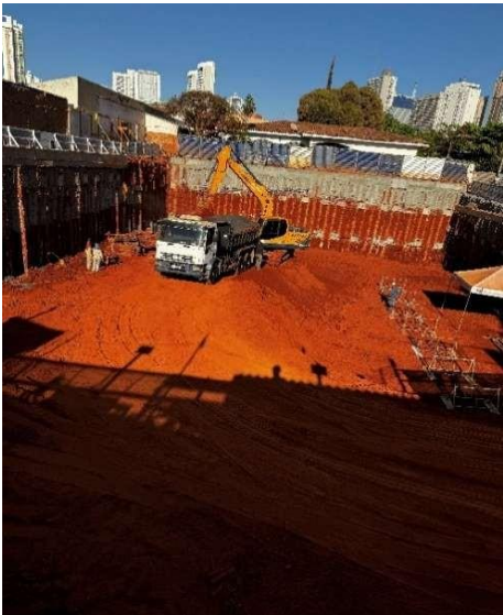
Figura 7 – Escavação até o nível do subsolo 2
