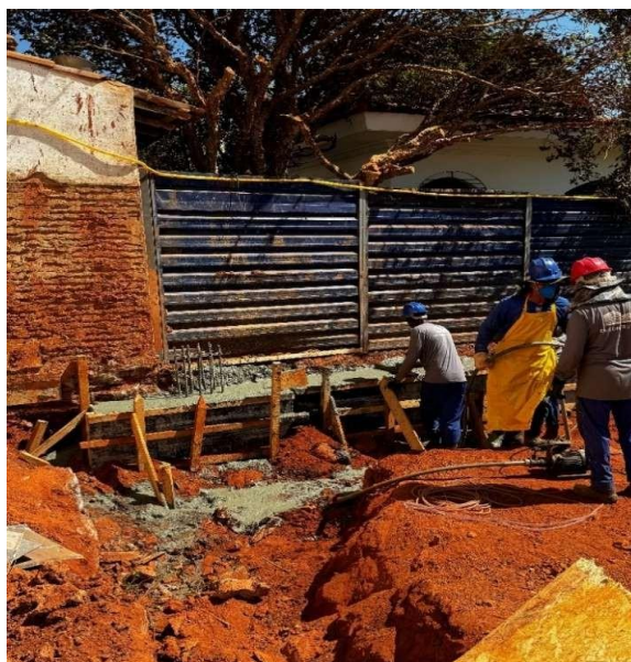
Figura 4 – Viga de Coroamento. Fonte: Autores (2025)
