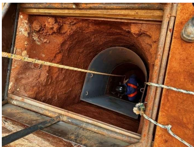
Figura 13 – Escavação dos tubulões. Fonte: Autores (2025)
