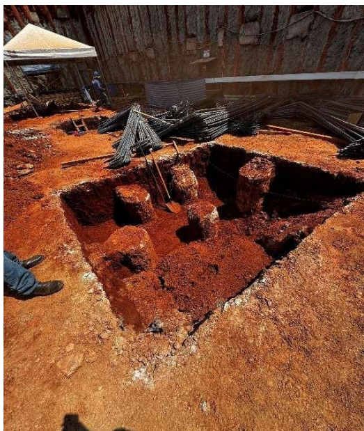
Figura 9 – Escavação dos blocos. Fonte: Autores (2025)
