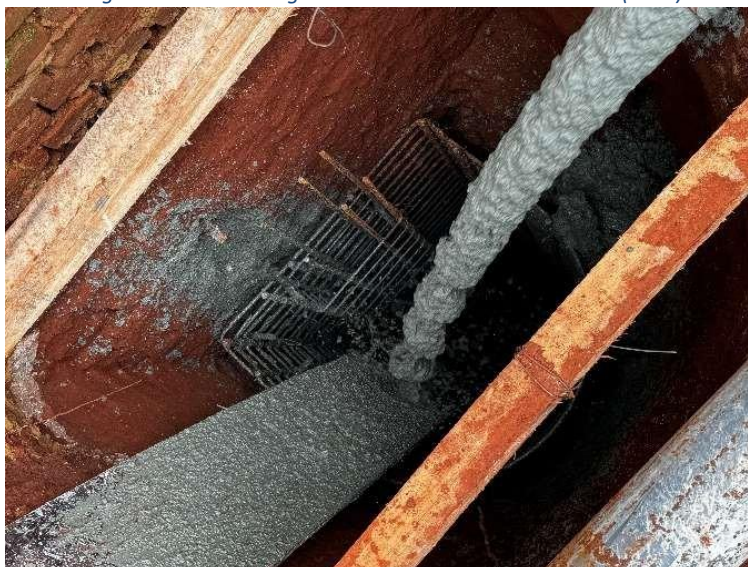
Figura 15 – Concretagem dos Tubulões. Fonte: Autores (2025)
