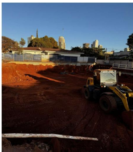
Figura 5 – Movimentação de terra. Fonte: Autores (2025)
