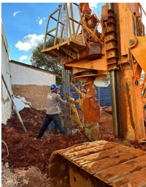
Figura 3 – Estaca de Contenção. Fonte: Autores (2025)
