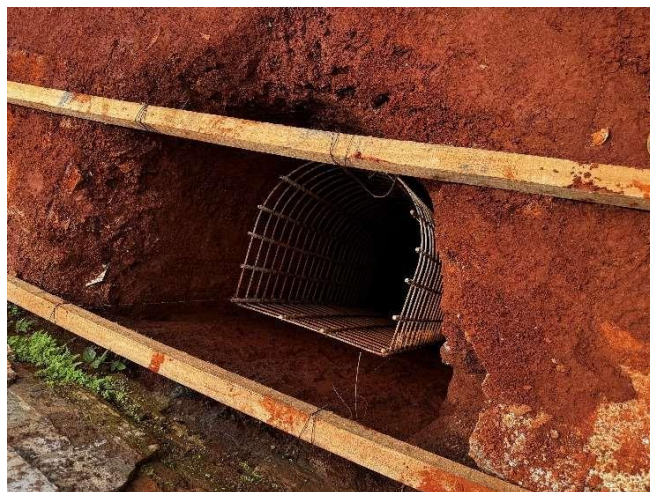
Figura 14 – Armação do Tubulão. Fonte: Autores (2025)
