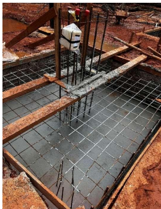
Figura 12 – Concretagem dos blocos. Fonte: Autores (2025)
