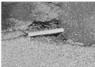
Diâmetro 100 a 200 mm (4 a 8") ou 200 a 400 mm (8 a 18") e profundidade 13 a  $\leq 25$  mm ( $\frac{1}{2}$ " a 1") e/ou diâmetro 100 a 200 mm (4 a 8") e profundidade  $> 25$  mm e  $\leq 50$  mm (1 a 2")
