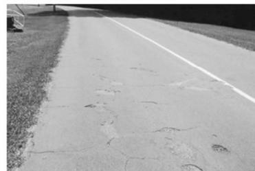
O agregado ou ligante foi consideravelmente desgastado. A textura da superfície é muito áspera e severamente corroída. As áreas corroídas têm menos de 10 mm (4") de diâmetro e menos de 13 mm (1/2") de profundidade; áreas corroídas maiores que isso são contadas como buracos. No caso de derramamento de óleo, o ligante asfáltico perdeu seu efeito de ligação e o agregado se tornou solto
