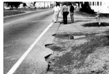
Trinca de abertura superior a 6 mm ou trinca selada com qualquer abertura e ruptura severa. Com desfiamento
