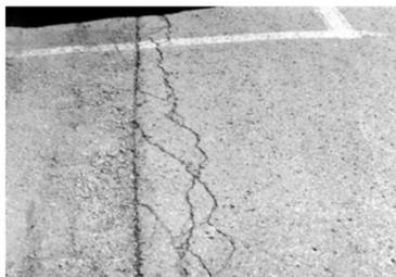
Trinca não selada com abertura entre 3 e 6 mm ou trinca selada de qualquer abertura de fissuramento. Sem desfiamento
