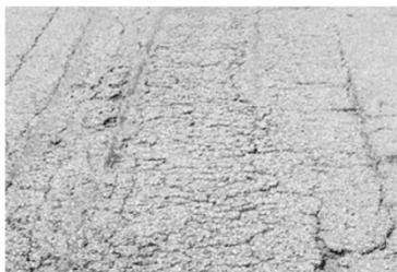
O agregado ou ligante está desgastado. A textura da superfície é moderadamente áspera e com corrosão. No caso de derramamento de óleo, a superfície é macia e pode ser penetrada com uma moeda
