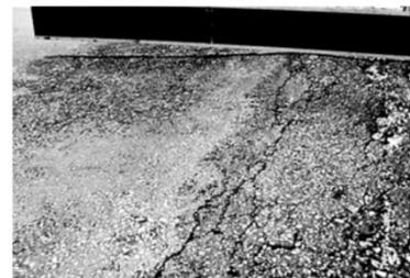
Elevações e recalques causam qualidade de condução de alta severidade
