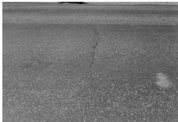
A largura da fissura não preenchida <10 mm (3/8") ou fissura preenchida de qualquer largura (enchimento em condições satisfatórias)
