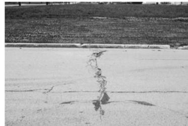
Qualquer fissura preenchida ou não, cercada por fissuras secundárias de média ou alta gravidade; fissuras não preenchidas >75 mm (3"); ou uma rachadura de qualquer largura onde aproximadamente 100 mm (4") do pavimento ao redor da fissura está severamente desintegrado ou quebrado
