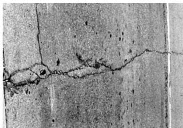
A largura da fissura não preenchida é maior ou igual a 10 mm (3/8") e <75 mm (3"); fissura não preenchida menor ou igual a 75 mm (3") cercada por fissuras secundárias leves; ou fissura preenchida de qualquer largura cercada por fissuras secundárias leves
