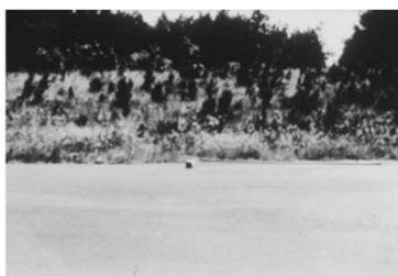
A severidade do inchamento é medida pela qualidade de passeio. Ondas de baixa severidade causam qualidade de passeio de baixa severidade e nem sempre são fáceis de ver, mas podem ser detectadas dirigindo no limite de velocidade sobre a seção do pavimento. Um movimento ascendente ocorrerá na ondulação se ela estiver presente. Inchamentos de média severidade causam qualidade de passeio de média gravidade e inchamentos de alta severidade causam qualidade do passeio de alta gravidade.
