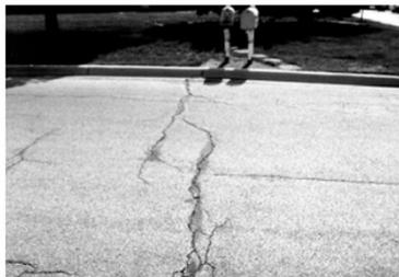
Abertura da trinca entre 1 e 3 mm. Sem erosão de bordo
