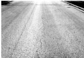
Fissuras capilares isoladas, com pouca interconexão entre si, sendo encontradas nas trilhas e sem erosão de borda
