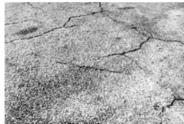
Abertura da trinca superior a 1 mm. Com erosão de bordo
