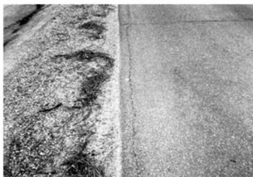
Trinca não selada com abertura inferior a 3 mm ou trinca selada de qualquer abertura em boas condições. Sem desfiamento
