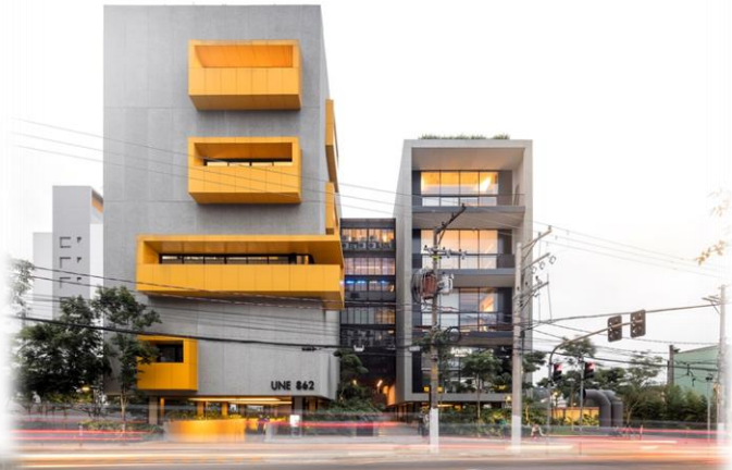
Fig.2.4: Vista da Fachada do Edifício, analisando a modulação e as cores e materiais utilizados.
