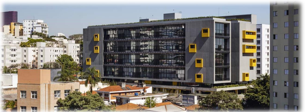
Fig.2.6: Vista lateral do edifício UNE, deixando claro os materiais e cores utilizados.
