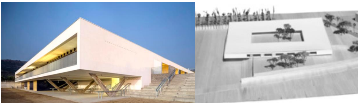
Figura 10. Foto da parte inferior destacando os pilares em forma de "v". Fonte: (Adriá Goula, 2017).
