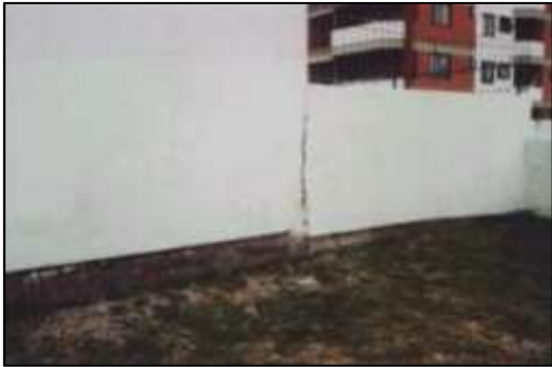
Figura 7 - Fissura vertical entre muro e a edificação indicando deficiência de amarração (esquerda) e fissura horizontal na interface alvenaria/laje, indicando movimentação térmica. Fonte: Magalhães (2004); Thomaz (1989).
