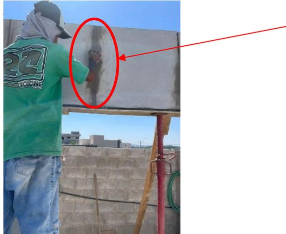
**Figura 4: Aplicação do rejunte ou massa acrílica para acabamento.**
