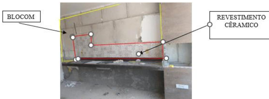
Figura 7: Assentamento do revestimento cerâmico no Blocom, sem a necessidade do emboço
