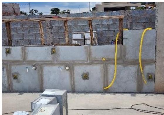
**Figura 5: Passagem Elétricas, Hidráulicas.**
