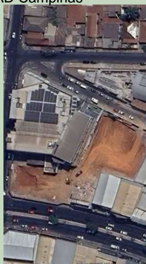
Figura 39: Vista Superior AD Campinas
