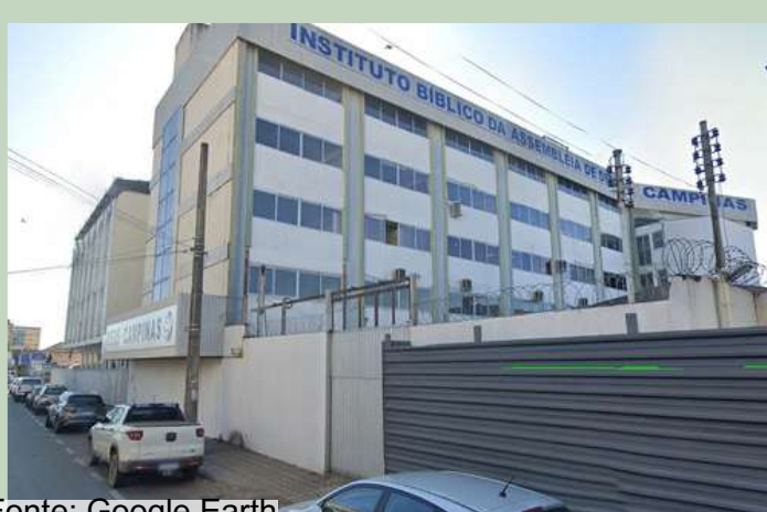
Figura 41: Instituto Bíblico AD Campinas
