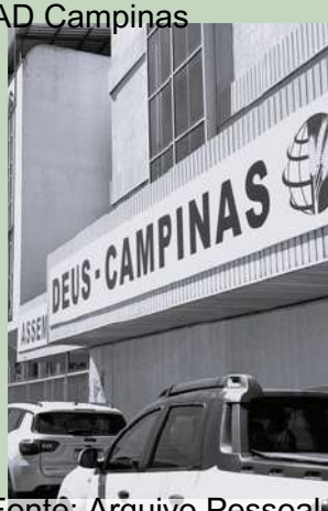
Figura 42: Vista Lateral AD Campinas
