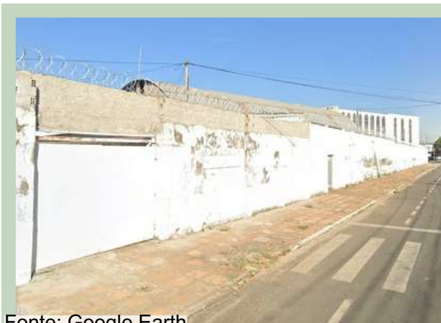
Figura 46: Vista Norte área de intervenção
