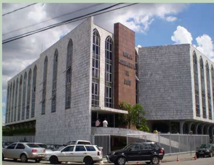
Figura 38: Fachada Oeste AD Campinas
