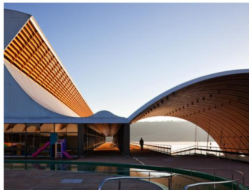
Figura 53. Centro de Reabilitação Sarah Kubitschek Lago Norte faz uso de sheds como método para maior conforto térmico e lumínico.
