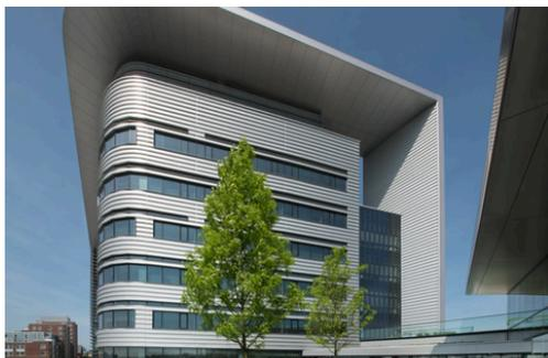
Figura 70. Hospital de Reabilitação Spaulding faz uso de placas de ACM e pele de vidro na composição da fachada.
