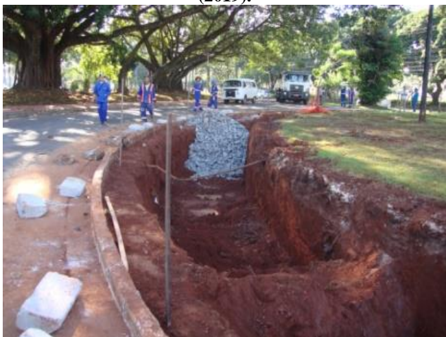
Figura 6 – Escavação. Fonte: Diário de Obra, SEINFRA (2019).
