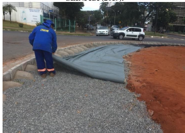
Figura 8 – Manta geotêxtil. Fonte: Diário de Obra, SEINFRA (2019).
