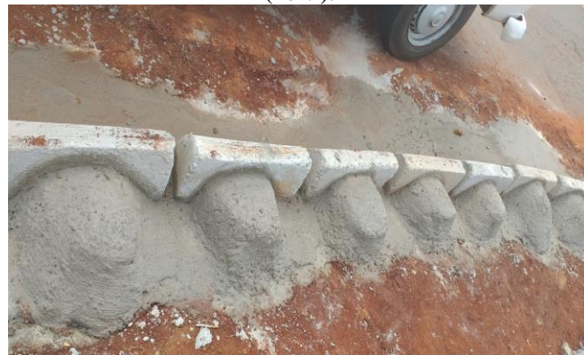
Figura 7 – Meio fio. Fonte: Diário de Obra, SEINFRA (2019).
