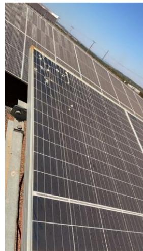
**Figura 14:** Relato fotográfico de um módulo sendo usado de lugar para depósito de fezes por uma coruja na usina fotovoltaica localizada no Polo industrial Senador Canedo, Goiás [Autores].
