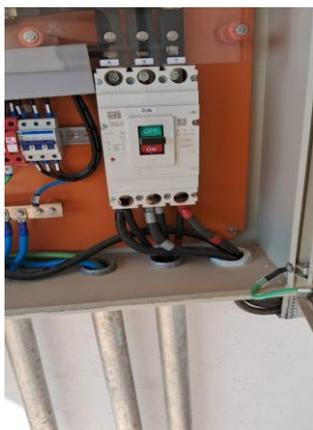
**Figura 11:** Relato fotográfico do Disjuntor geral antes das modificações necessárias para garantir o pleno funcionamento da usina fotovoltaica [Autores].
