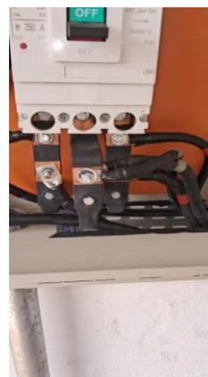
**Figura 12:** Modificações implementadas na saída do disjuntor após as recomendações dos estudantes e do eletrotécnico [Autores].
