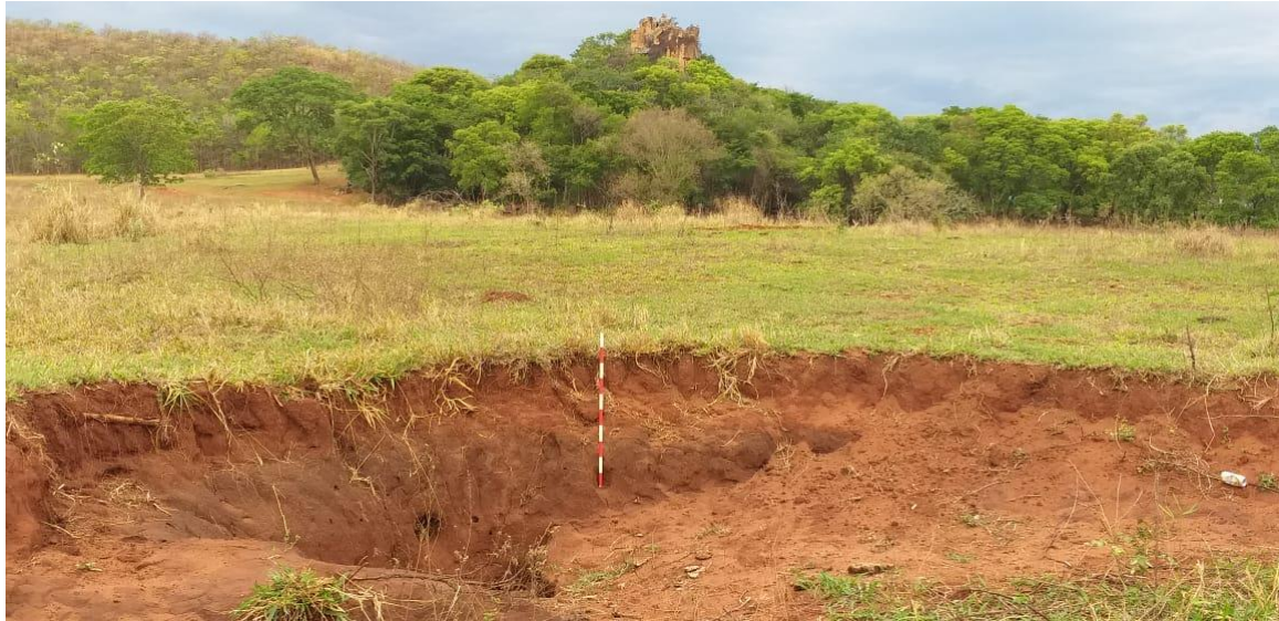
Figura 51. Detalhe de erosão nas proximidades do sítio GO-JA-02. Fonte: Acervo Projeto Serranópolis.
