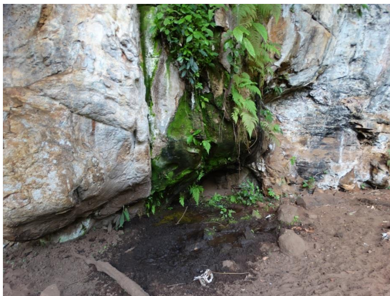
Figura 43. Acumulo de água no interior do abrigo proveniente da percolação de água da superfície. Fonte: Acervo Projeto Serranópolis.
