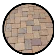
Piso Intertravado de concreto
