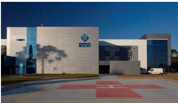
(Fachada Oeste Hospital do Rocio)
