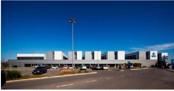
(Fachada Norte Hospital do Rocio)
