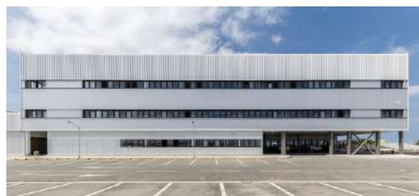
(Fachada Oeste Hospital de Manta - Equador) Site: www.archdaily.com.br , Fotografias: BIKUBIK acesso em: 29-03-2020
