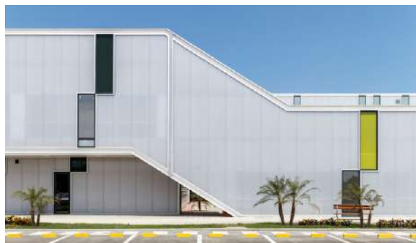
(Fachada Sul Hospital de Manta - Equador) Site: www.archdaily.com.br , Fotografias: BIKUBIK acesso em: 29-03-2020
