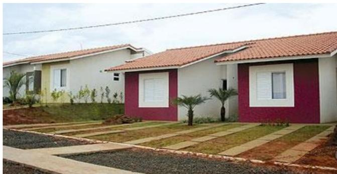
**Figura 12 - Casas térreas construídas com Sistema de Paredes de Concreto com acabamento finalizado**
