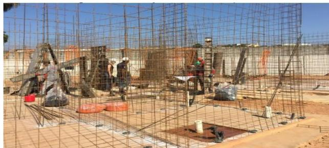
**Figura 4 - Tela eletrosoldada para a amarração e estruturação das paredes**
