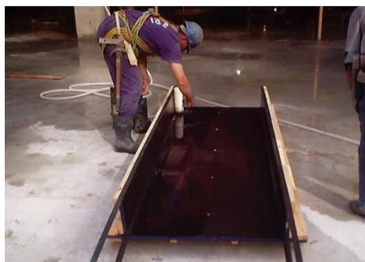
**Figura 9 - Aplicação do desmoldante nas fôrmas**
