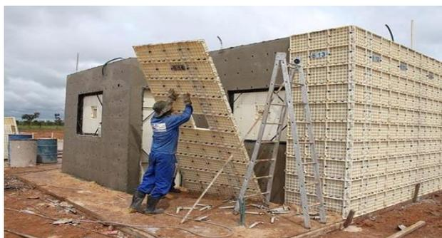
**Figura 11 - Desfôrma das paredes de concreto**
