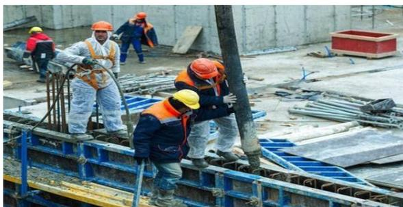
**Figura 10 - Concretagem da parede de concreto**
