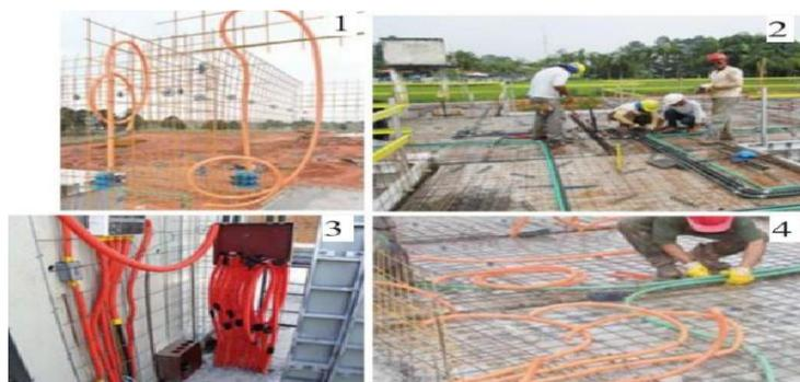
**Figura 7 - Instalações elétricas: 1) Caixas presas com grapa; 2) Execução de instalação e fixação dos condutores; 3) Instalação elétrica nas paredes; 4) Fixação dos condutores**
