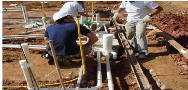
**Figura 3 - Instalações hidráulicas e pontos de conexão embutidos na fundação**
