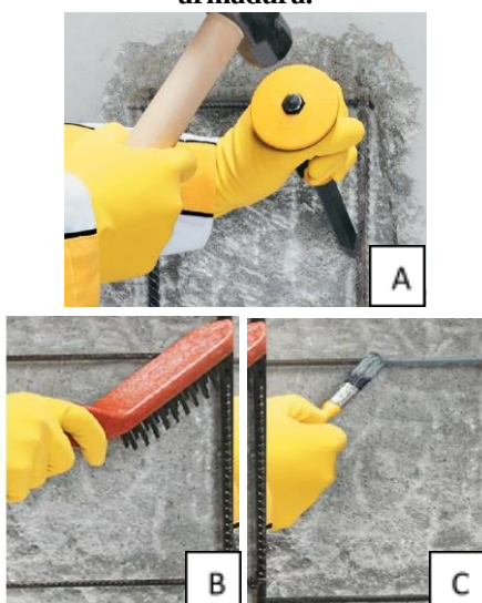
Figura 7 - Tratamento de corrosão em armadura. A) Retirada do concreto na área a ser tratado. B) Limpeza das ferragens com escova de aço para retirada de ferrugem. C) Aplicação de produto anticorrosivo na armadura.
