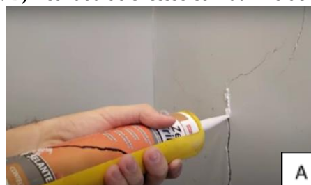
Figura 4 – Tratamento de trincas. A) Aplicação do selante. B) Retirada do excesso com auxílio de espátula.
