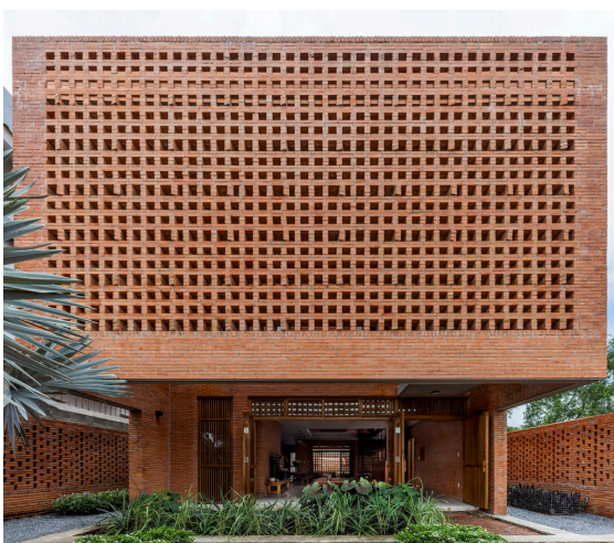
Elemento vazado e proteção de superfície
