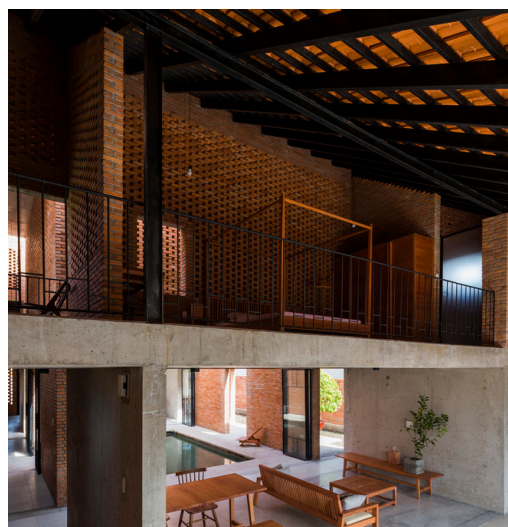
Inclinação da cobertura e elemento vazado criam efeito chaminé
