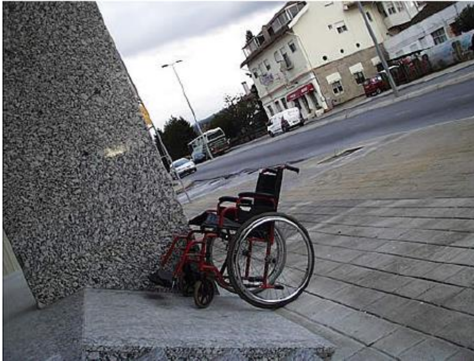
Anexo 1 - Rampa de acesso para cadeirantes construída sem observância à NBR 9050. Via: http://44arquitetura.com.br/2016/06/rampa-de-acessibilidade-aprenda-projetar/
