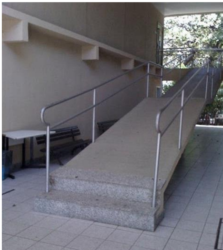
Anexo 4 - rampa para acesso de cadeirantes ao piso superior, em que não é possível ter acesso à própria rampa. Via: https://casadaptada.com.br/2016/06/algumas-dicas-para-ajudar-um-cadeirante/
