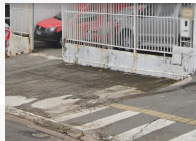
Fig - Falta de continuidade no piso tátil ao longo de uma quadra na Avenida 85. Fonte: Google Maps
