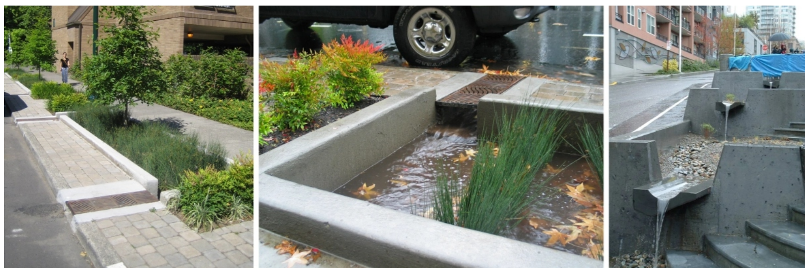
Fig. X- Jardins de chuva implantados nas calçadas de Seattle, EUA Foto: Nate Cormier
