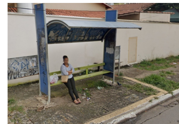
Fig. 12 Ponto de ônibus no Trecho C. Fonte: Google Street
