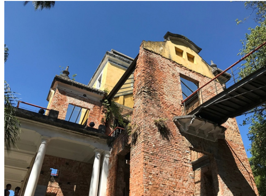
FIGURA 18: PARQUE DAS RUÍNAS FONTE: ARCHDAILLY
