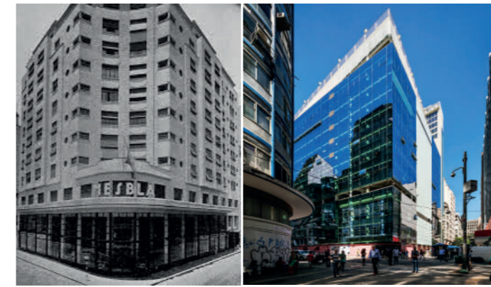
fachadas: antes e depois. Foto: Nelson Kon
