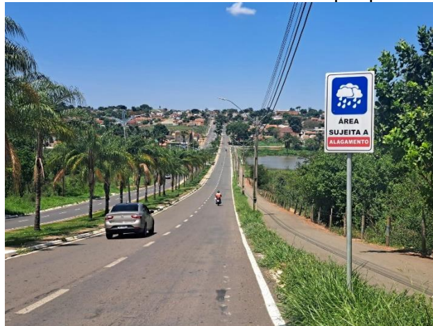
Figura 29 – Visão do relevo da R. Dr. Anuar Auad e aviso por placa do risco de alagamento
