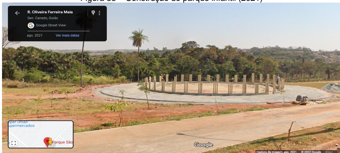
Figura 33 – Construção do parque infantil (2021)
