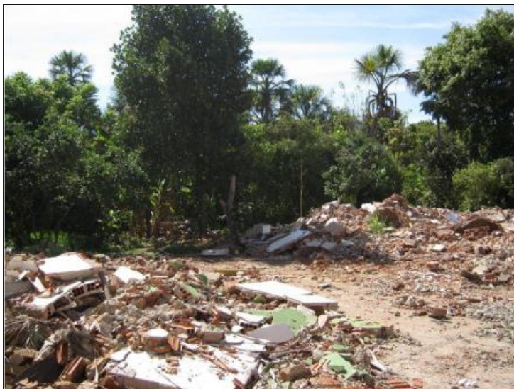
Figura 14 - Entulho proveniente das demolições / remoção das famílias
