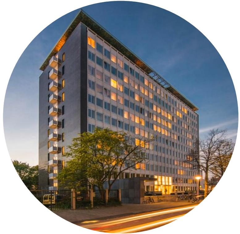
O objetivo era preservar a aparência externa e renová-la, enquanto os apartamentos foram facilmente incorporados à estrutura pré-existente de pilares e pisos de concreto. Somente nas fachadas norte e sul foram feitas aberturas adicionais para melhorar a entrada de ventilação e luz natural no espaço.
