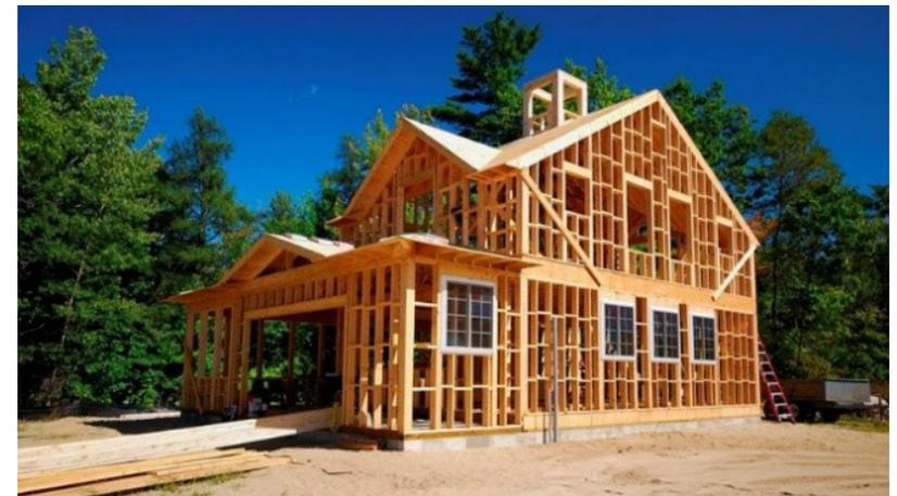
Figura n13 Estrutura de uma residência em Wood frame:
