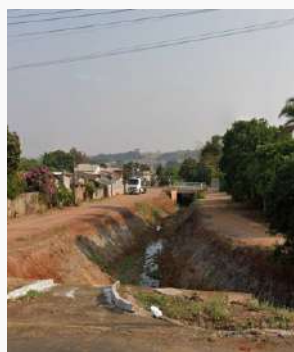
IMAGEM 22: Trecho Córrego Cambauva. Fonte: Autor.
