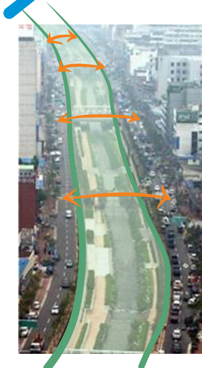
IMAGENS 50 a 52: Processo de renaturalização do Canal de Cheonggyecheon. Fonte: Site Viver Viagem.
