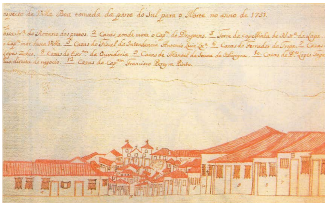
Figura 1- Vila Boa – Vista tomada do Sul para o Norte, 1751 6
