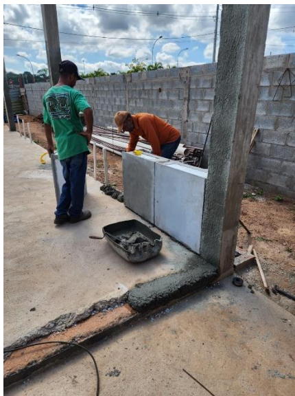
Figura 5 - Regularização da base
