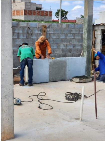
Figura 3 – Marcação da Alvenaria
