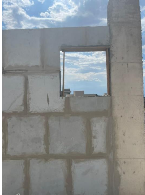
Figura 9 - Abertura de janela
