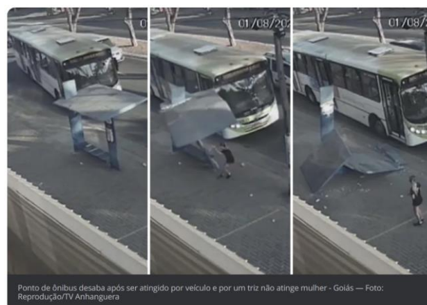
Figura 22: Ponto de ônibus desabando
