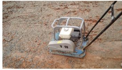
(a) Primeira etapa: escavação, compactação do subleito e colocação da geomembrana
