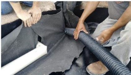
(b) Segunda etapa: montagem da trincheira drenante e execução da base
