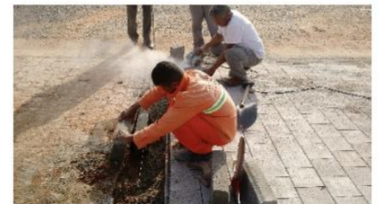
(c) Terceira etapa: nivelamento da areia de assentamento, encaixe dos blocos e fechamento da contenção lateral
