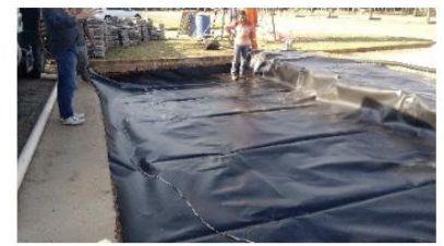
(a) Primeira etapa: escavação, compactação do subleito e colocação da geomembrana
