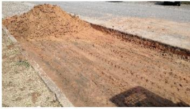
(a) Primeira etapa: escavação, compactação do subleito e colocação da geomembrana
