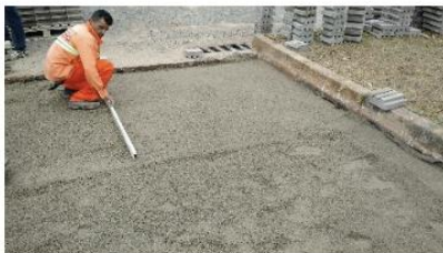
(c) Terceira etapa: nivelamento da areia de assentamento, encaixe dos blocos e fechamento da contenção lateral
