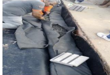
(b) Segunda etapa: montagem da trincheira drenante e execução da base
