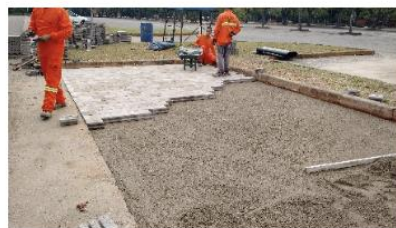
(c) Terceira etapa: nivelamento da areia de assentamento, encaixe dos blocos e fechamento da contenção lateral
