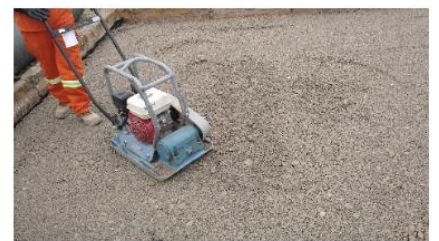
(b) Segunda etapa: montagem da trincheira drenante e execução da base
